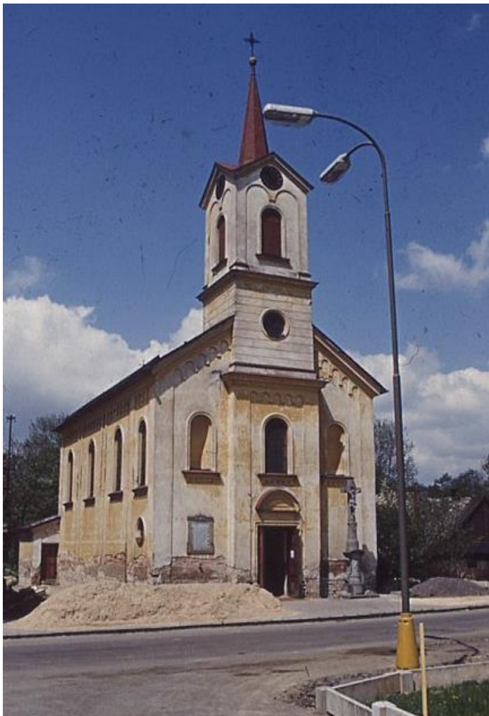
Oprava kostela ve Verměřovicích (1970)
